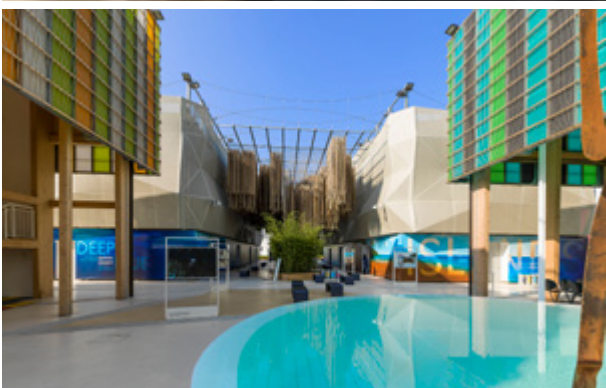
EXPO 2015 – Padiglioni ISOLE MARE E CIBO- Realizzazione impianti tecnologici PHP Rubner Objektbau S.r.l.
