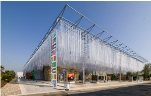
EXPO 2015 – Padiglioni ZONE ARIDE Realizzazione impianti tecnologici PHP Rubner Objektbau S.r.l.
