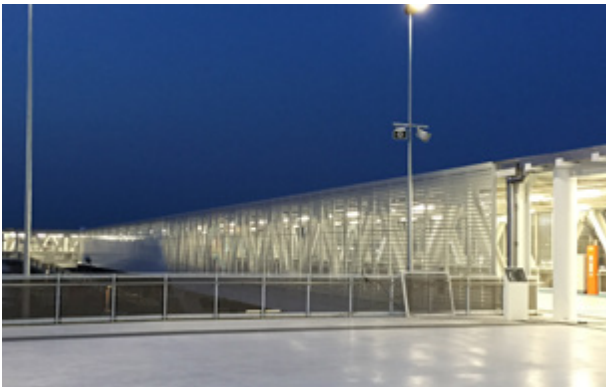
Passerella EXPO 2015 - Milano Realizzazione degli impianti elettrici, elettronici, speciali e di emergenza.
