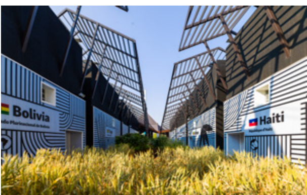
EXPO 2015 – Padiglioni CEREALI E TUBERI Realizzazione impianti tecnologici PHP Rubner Objektbau S.r.l.
