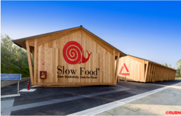
EXPO 2015 – Padiglioni SLOW FOOD Realizzazione impianti tecnologici PHP Rubner Objektbau S.r.l.
